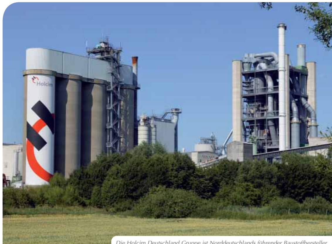
Die Holcim Deutschland Gruppe ist Norddeutschlands führender Baustoffhersteller (Zement, Beton, Sand, Kies und Splitt). Zement wird in den Werken Lägerdorf (Foto), Schleswig-Holstein, und Höver, Niedersachsen, hergestellt
